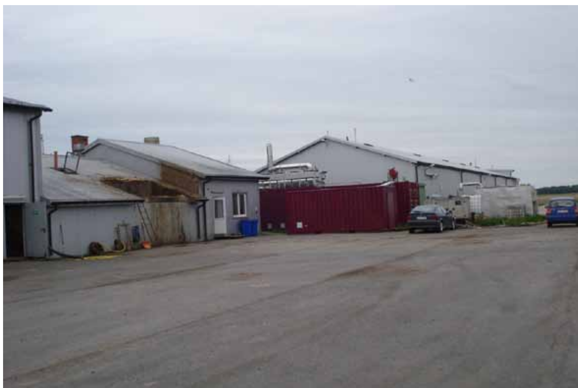
Foto: Widok ogólny instalacji Biogazowni w Zaściankach
