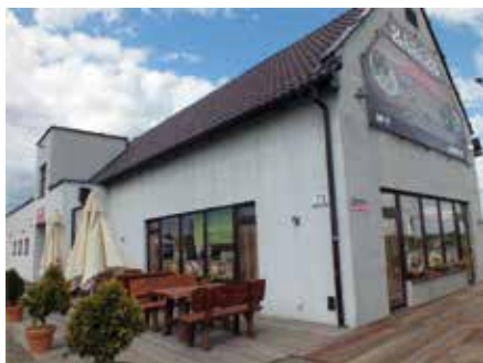
Budowa budynku gastronomicznego wraz z zakupem wyposażenia
