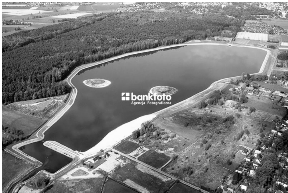
Ryc. 2. Dwa zbiorniki: po lewej zbiornik wstępny, po prawej retencyjny (fot. bankfoto.com.pl) Two tanks: on the left - preliminary tank, on the right – reservoir
