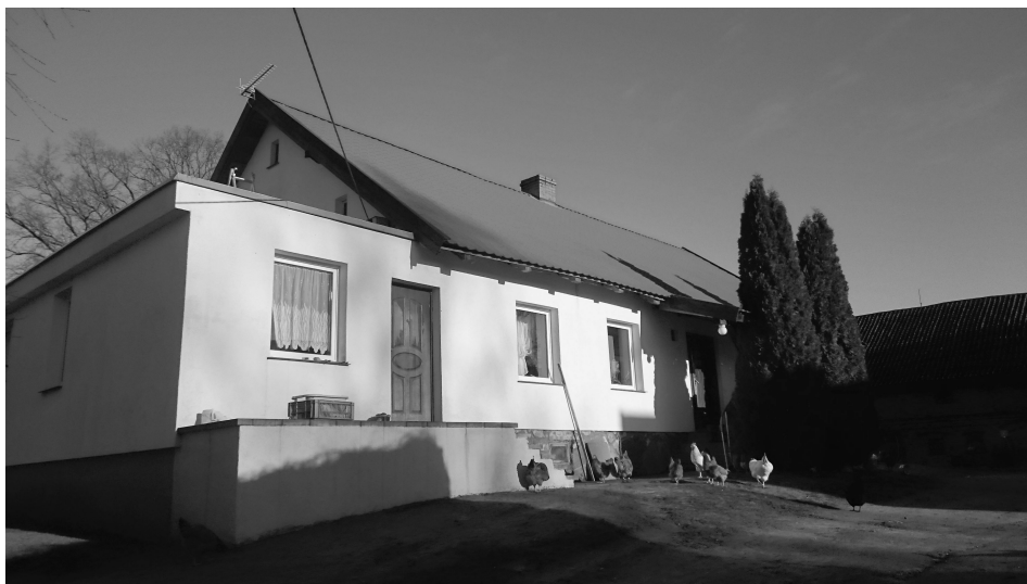
Fot. 3. Silnie przekształcony budynek mieszkalny (fot. P. Pawelec, listopad 2015) A highly converted residential building (photo P. Pawelec, November 2015)
