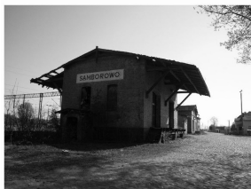
Fot. 7. Zabytkowy magazyn Pic. 7. Historic warehouse
