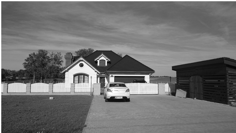
Fot. 5. Estetyczny, współczesny budynek niewpasowujący się w otoczenie (fot. P. Pawelec, październik 2015) An aesthetic modern building not fitting in the surrounding (photo P. Pawelec, October 2015)
