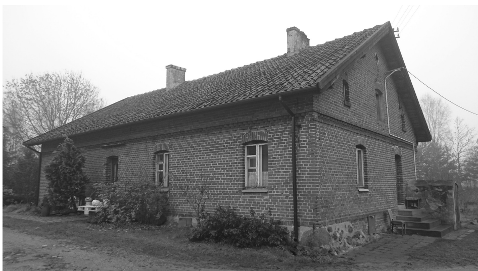
Fot. 4. Nieprzekształcony budynek mieszkalny (fot. P. Pawelec, listopad 2015) An unconverted residential building (photo P. Pawelec, November 2015)
