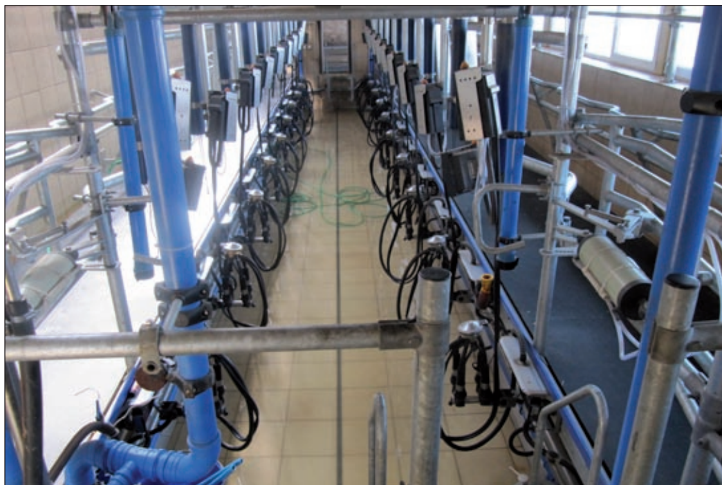
ZD Chorzelów - hala udojowa po modernizacji
