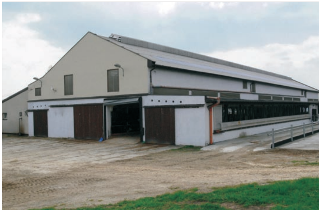
ZD Rudawa - zmodernizowany budynek obory wolnostanowiskowej w Kobylanach
