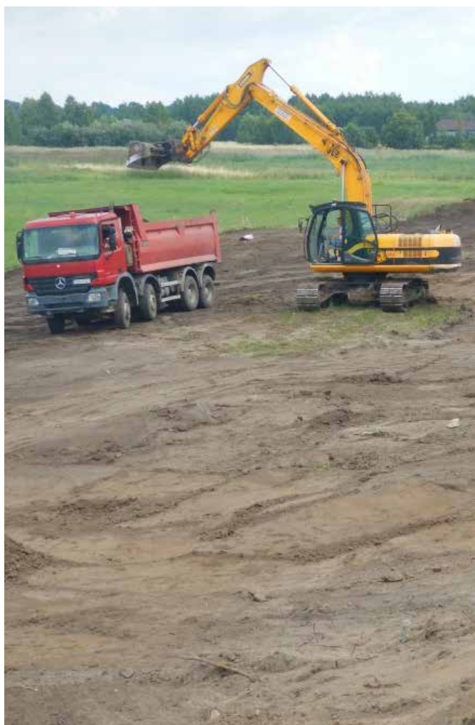
Fot. 3.2. Destrukcja warstwy próchnicznej gleby związana z budową drogi (autor: T. Jadczyzyn)
