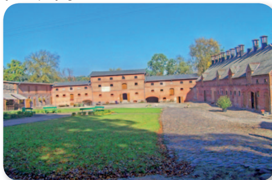
Fot. Centrum Edukacji Przyrodniczej wraz z odbudową zabytkowego folwarku w Mniszkach. (Archiwum UG)
