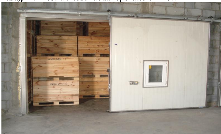
Fot. Rozbudowa przechowalni owoców
