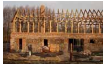
Oboro-stajnia w trakcie i po remoncie
