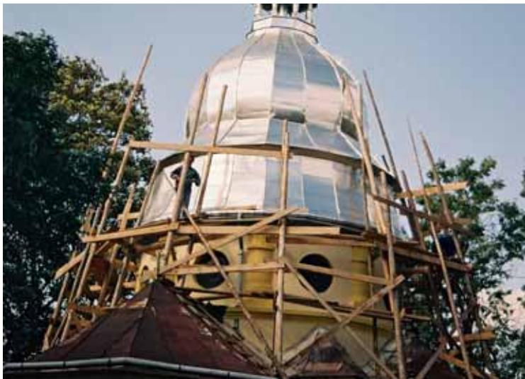
Cerkiew w trakcie remontu
