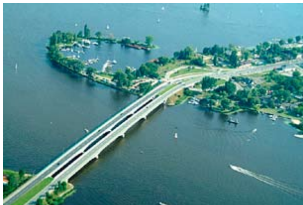
Photo 172. Bridge in Zegrze. From the archive of Urząd Gminy Nieporęt.
