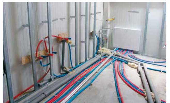
Prace przy budowie chłodni trwają
