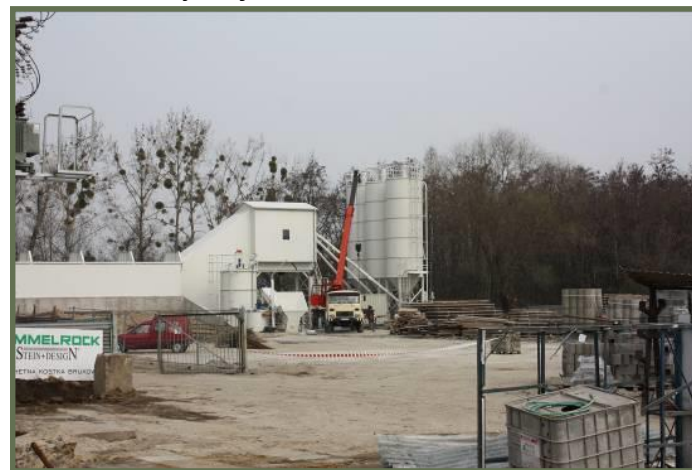
Chorula – nowa inwestycja - węzeł betoniarski firma „MB Czarnecki”
