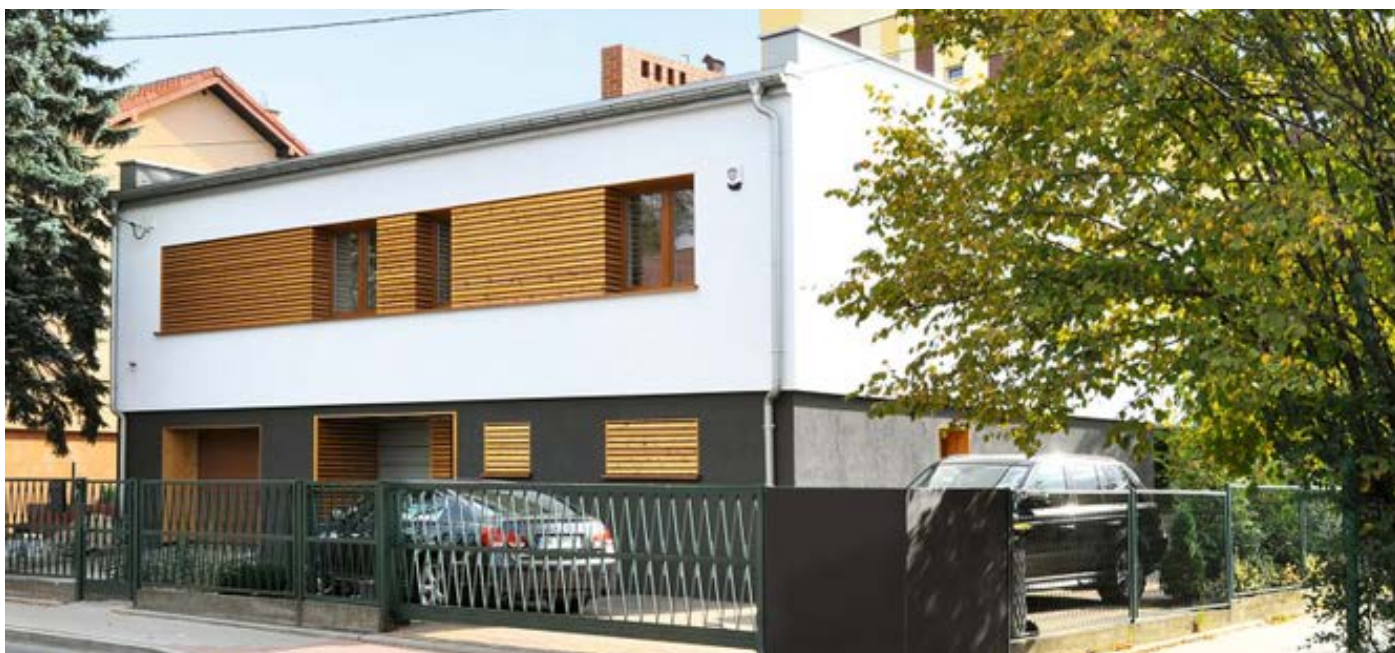
Rys. 2.9. Przykład termomodernizacji budynku mieszkalnego
