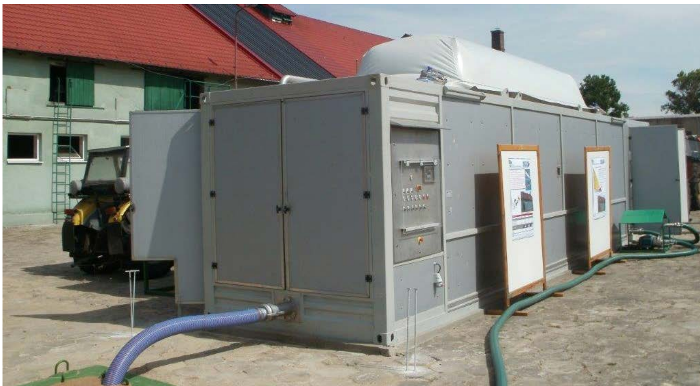
Rys. 6.3. Fot. Z. Ginalski. Instalacja kontenerowej biogazowni rolniczej
