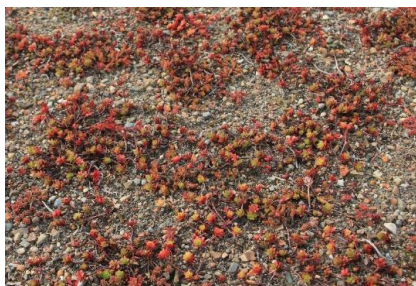
Dach o charakterze ekstensywnym
