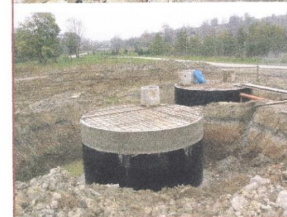
Przykład wdrożenia technologii budowy zbiorników na gnojówkę metodą formy ślizgowej UMZ-2 w gospodarstwie ASTIR w Izbach.
