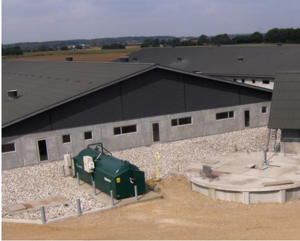
Fot. 6. Zbiornik z kwasem na zewnątrz budynku do zakwaszania gnojowicy „in house” (fot. JH Agro)
